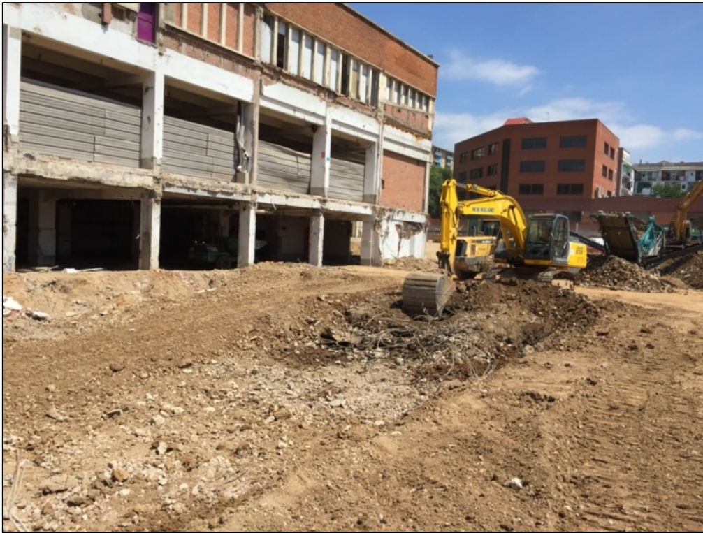
Fotografia 88. Treballs de rebaix sediments contemporanis UE200 sector C.
