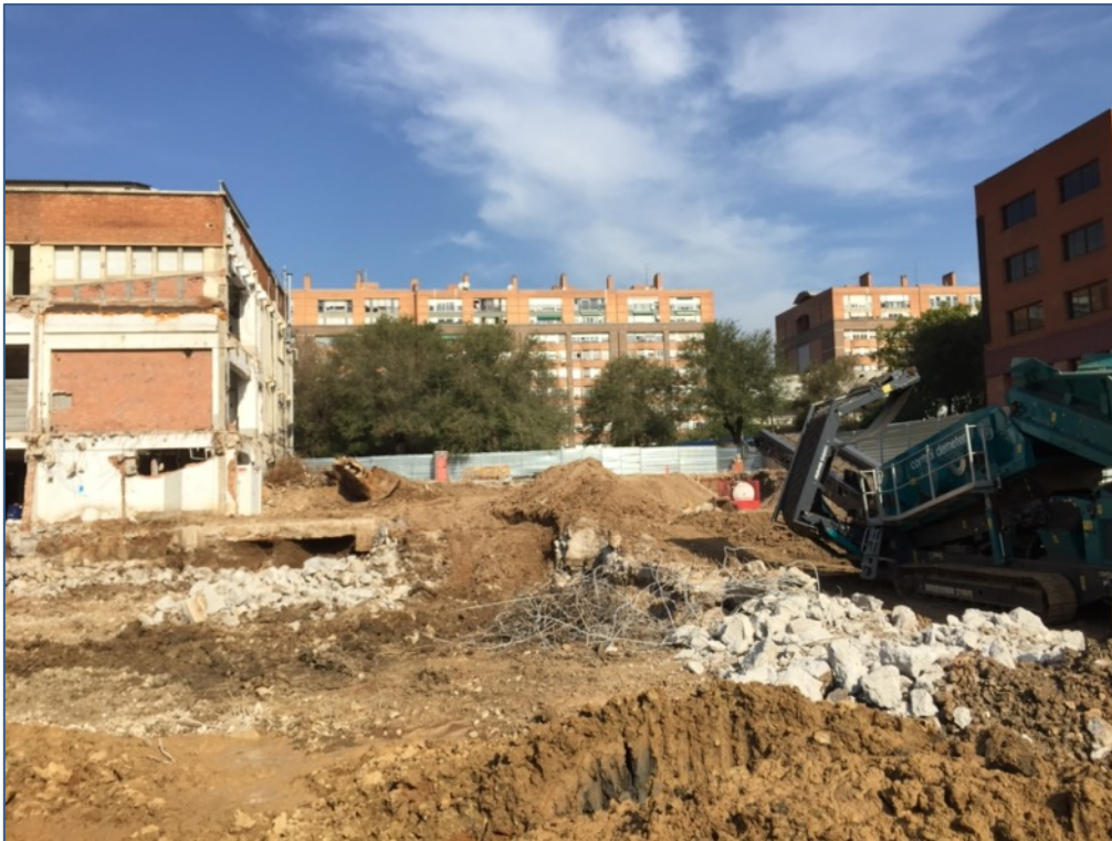
Fotografia 143. Estructures de formigó documentades al sector D.
