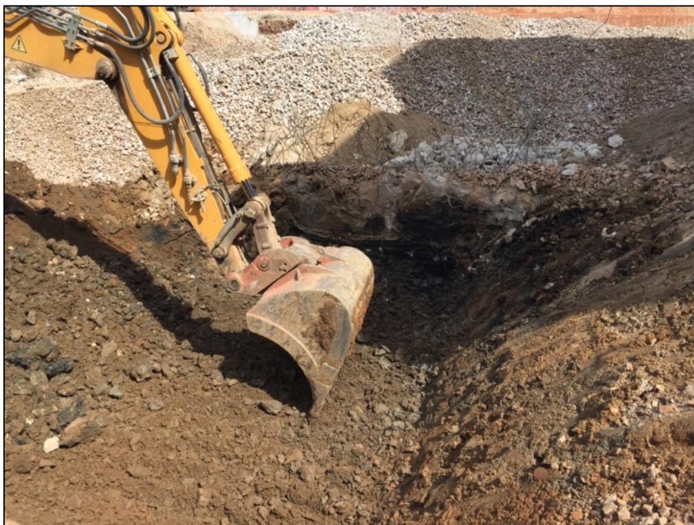
Fotografia 72. Rebaix estrat UE105.
