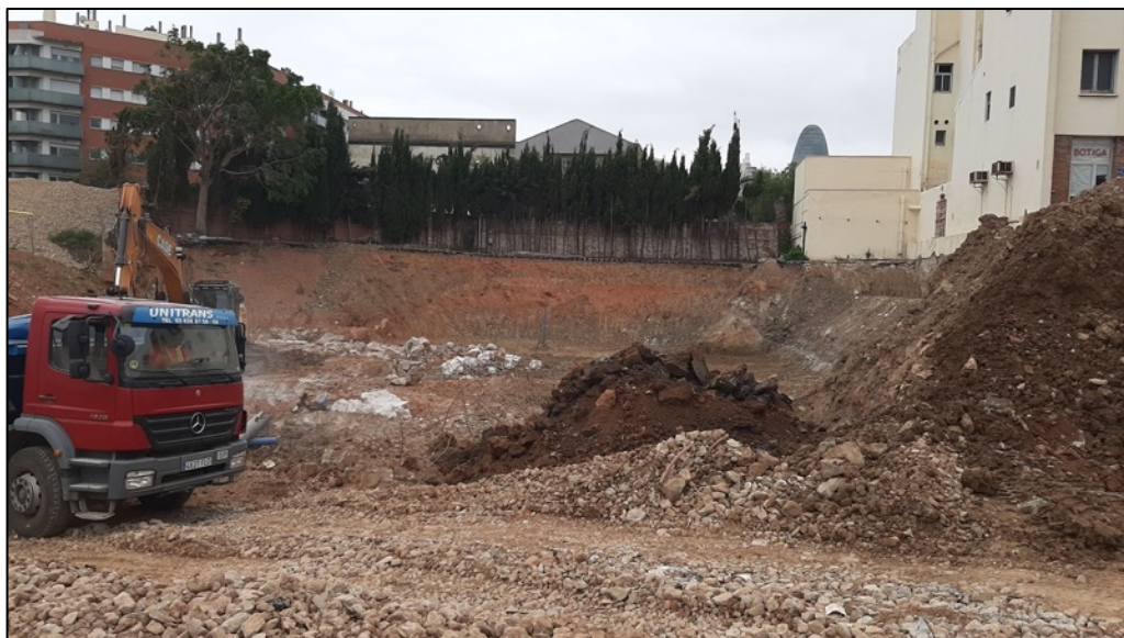
Fotografia 7. Treballs d'extracció de terres i graves contemporànies.
