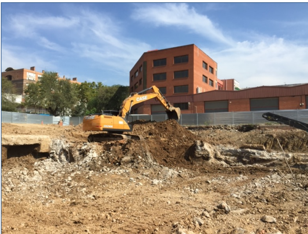
Fotografia 144. Desmuntatge estructures de formigó.
