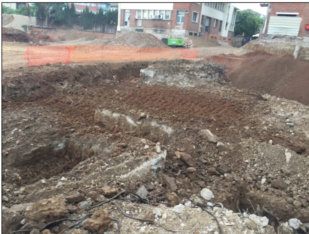
Fotografia 96. Fonamentacions de formigó localitzades en la zona central del sector C.
