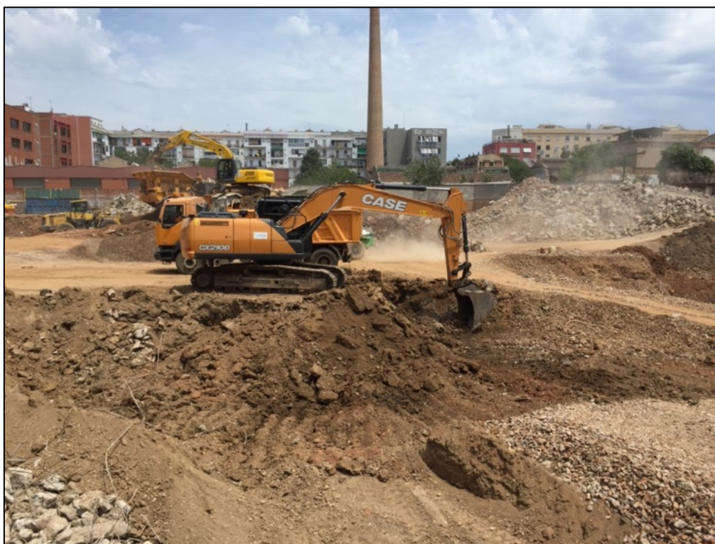
Fotografia 55. Rebaix estrats UE100 i UE101.
