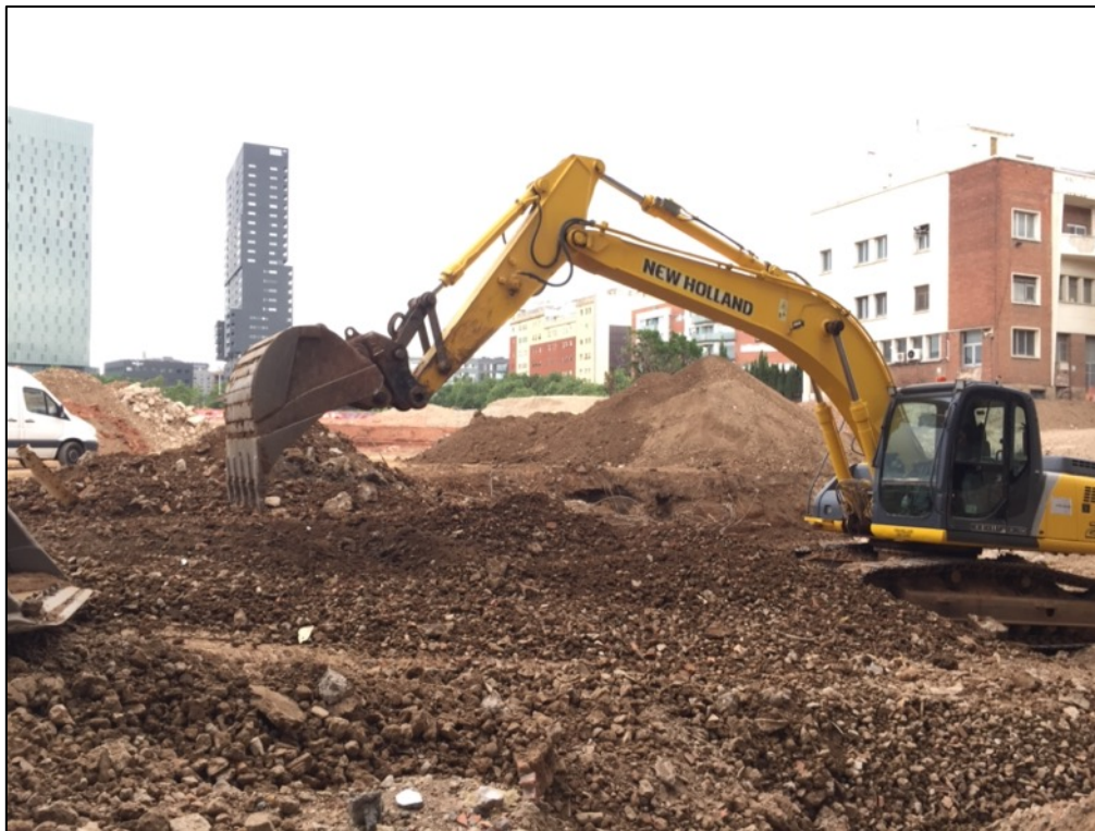
Fotografia 108. Rebaix estrats contemporani de la zona nord.
