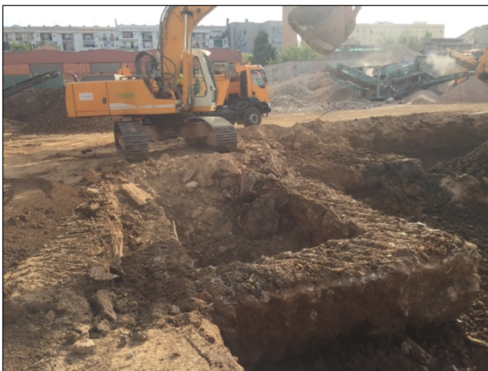
Fotografia 97. Localització d'estructures de formigó contemporànies.
