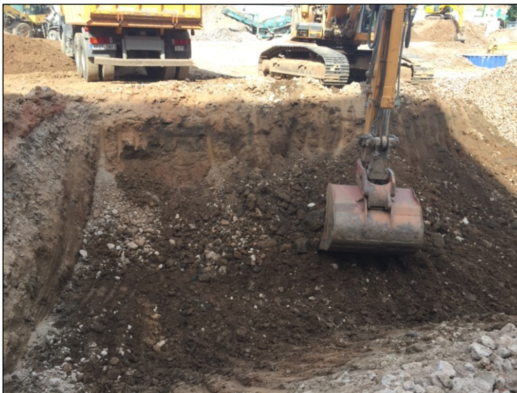
Fotografia 116. Rebaix UE205 en zona sud a tocar de l'accés del carrer Bilbao.
