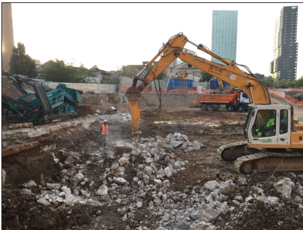
Fotografia 54. Desmuntatge estructures de formigó contemporànies.
