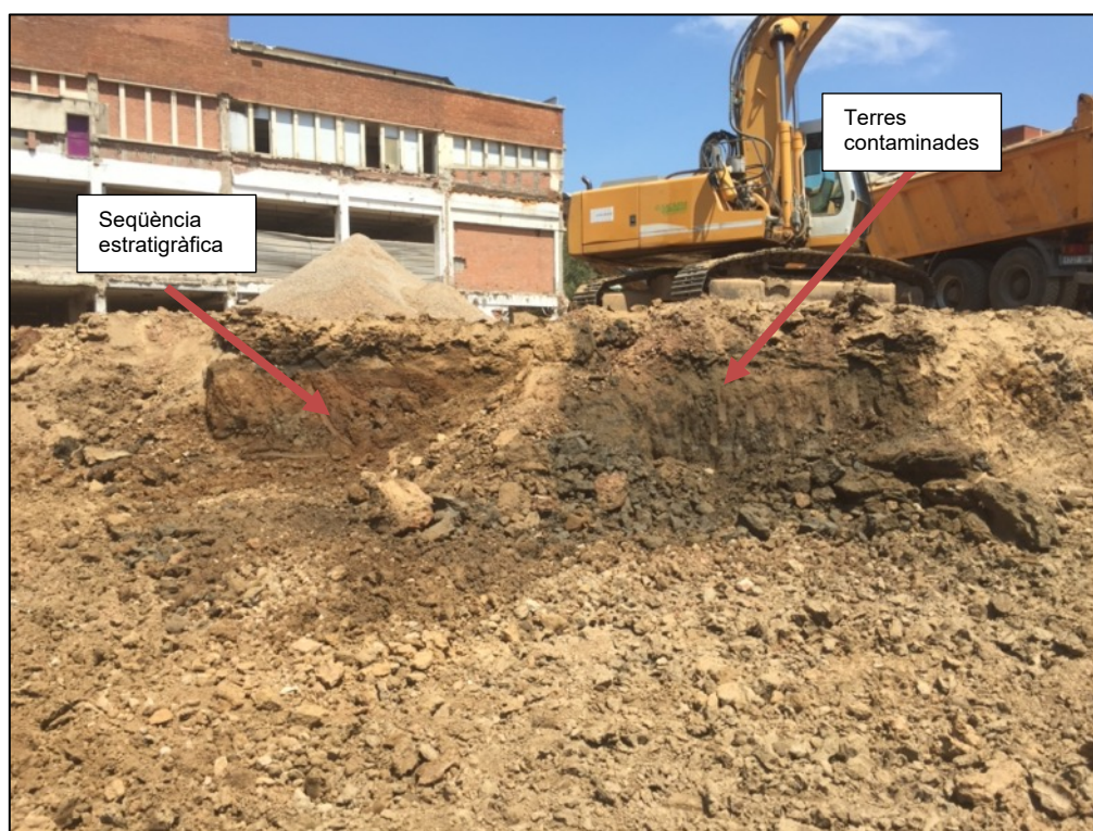
Fotografia 80. Vista tall estratigràfic en la zona central amb terres contaminades.
