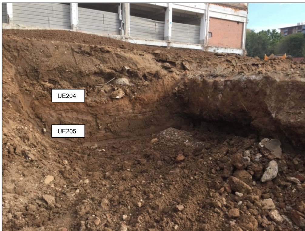
Fotografia 136. Estratigrafia existent afectada per estructures de formigó.
