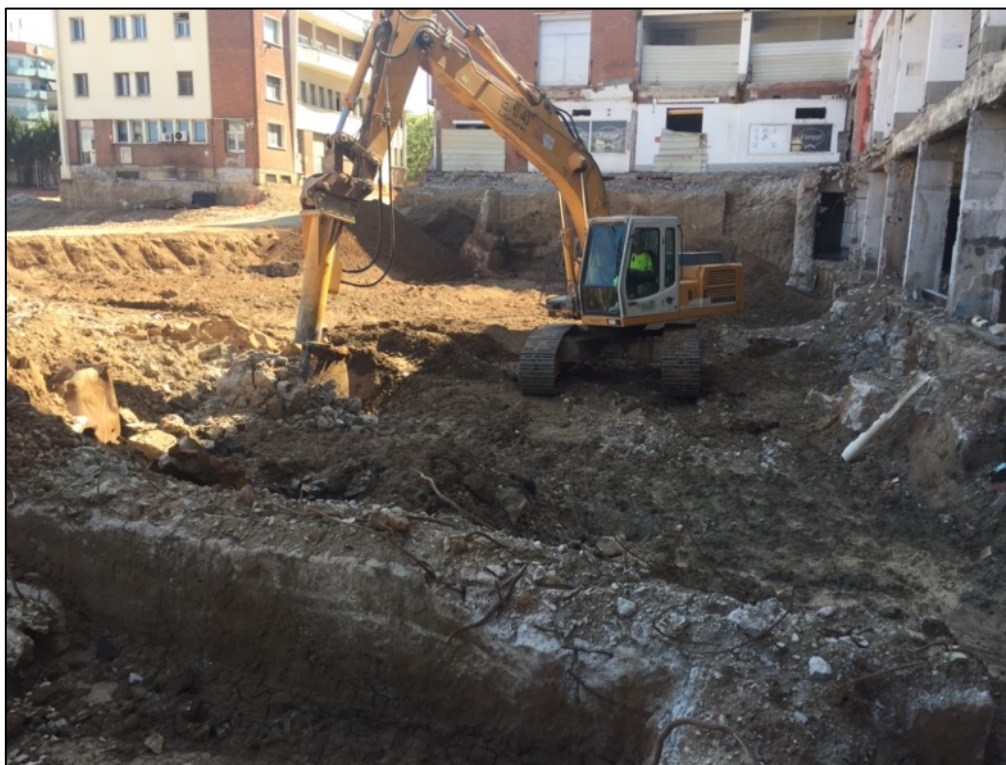
Fotografia 101. Desmuntatge antigues estructures fàbrica Farggi.
