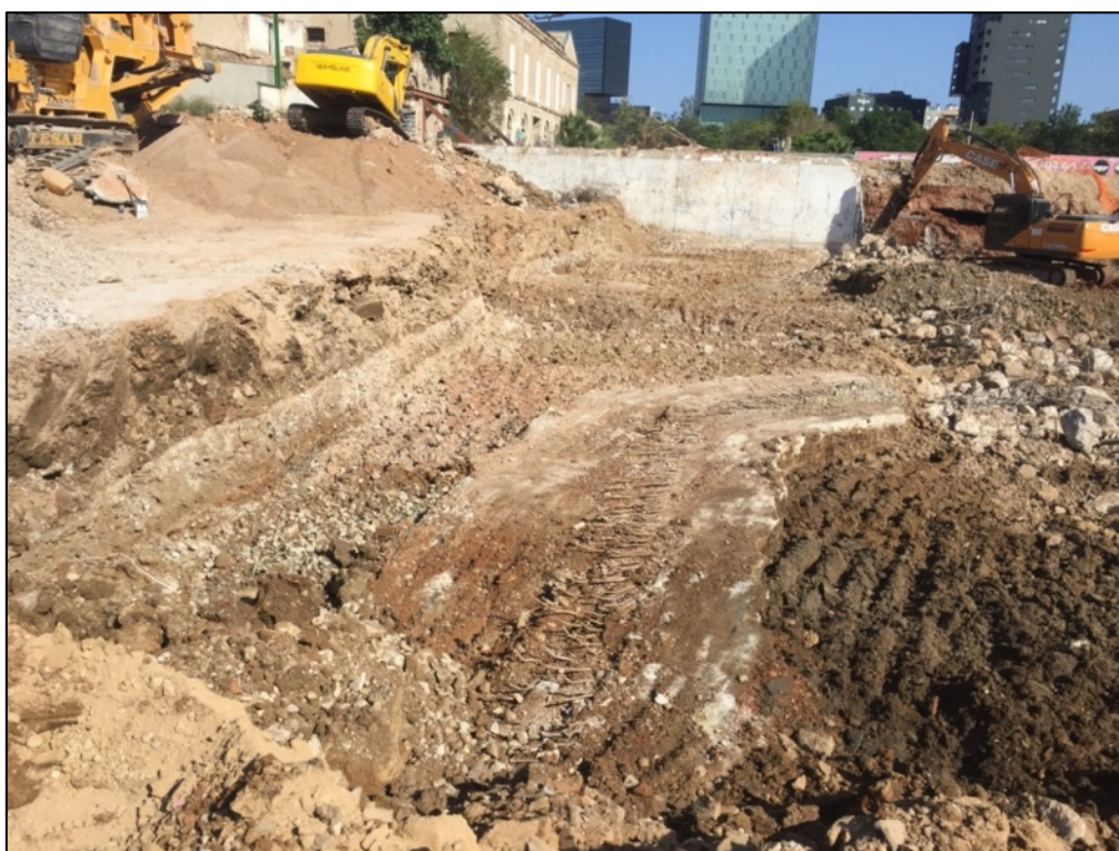
Fotografia 52. Detall riosta de fonamentació de formigó.
