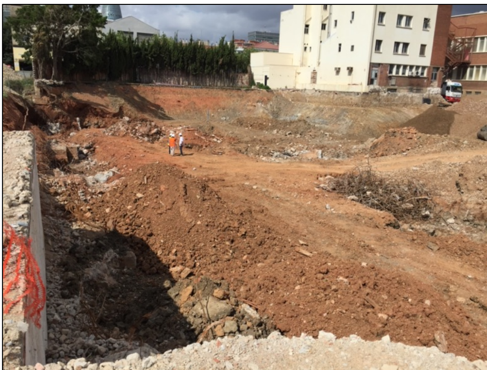
Fotografia 2. Vista general del sector A amb rebaixos de terres contemporànies UE300.
