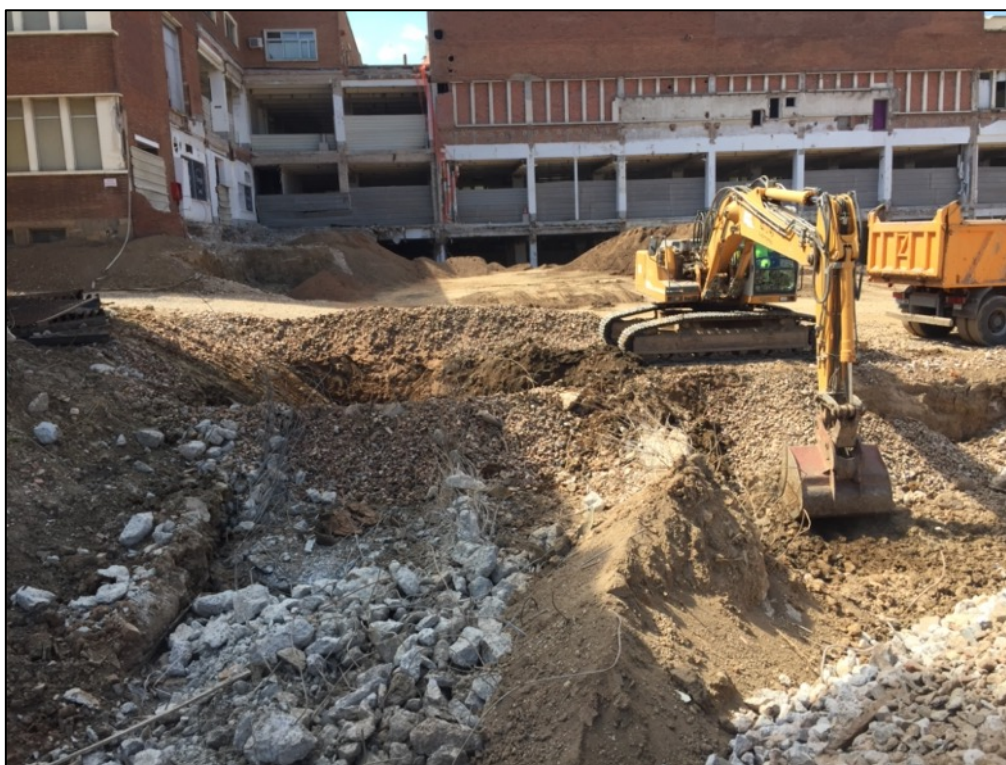
Fotografia 59. Extracció restes de formigó estructures repicades.
