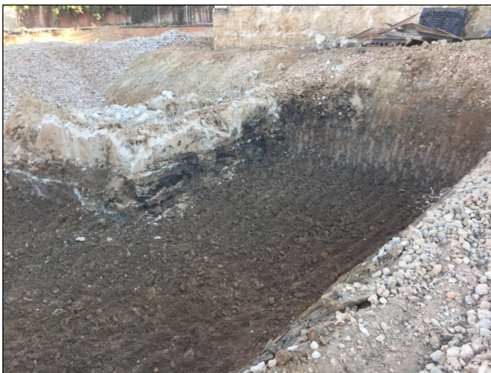
Fotografia 49. Vista del dipòsit de formigó localitzat en la zona sud del sector B.
