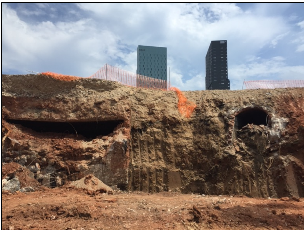
Fotografia 17. Detall de galeries i col·lectors contemporanis localitzats al tall oriental del sector A un cop enretirat el mur de façana.
