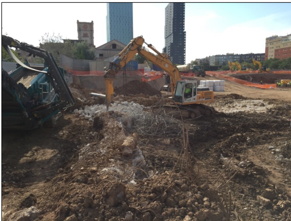
Fotografia 103. Desmuntatge estructures de formigó.
