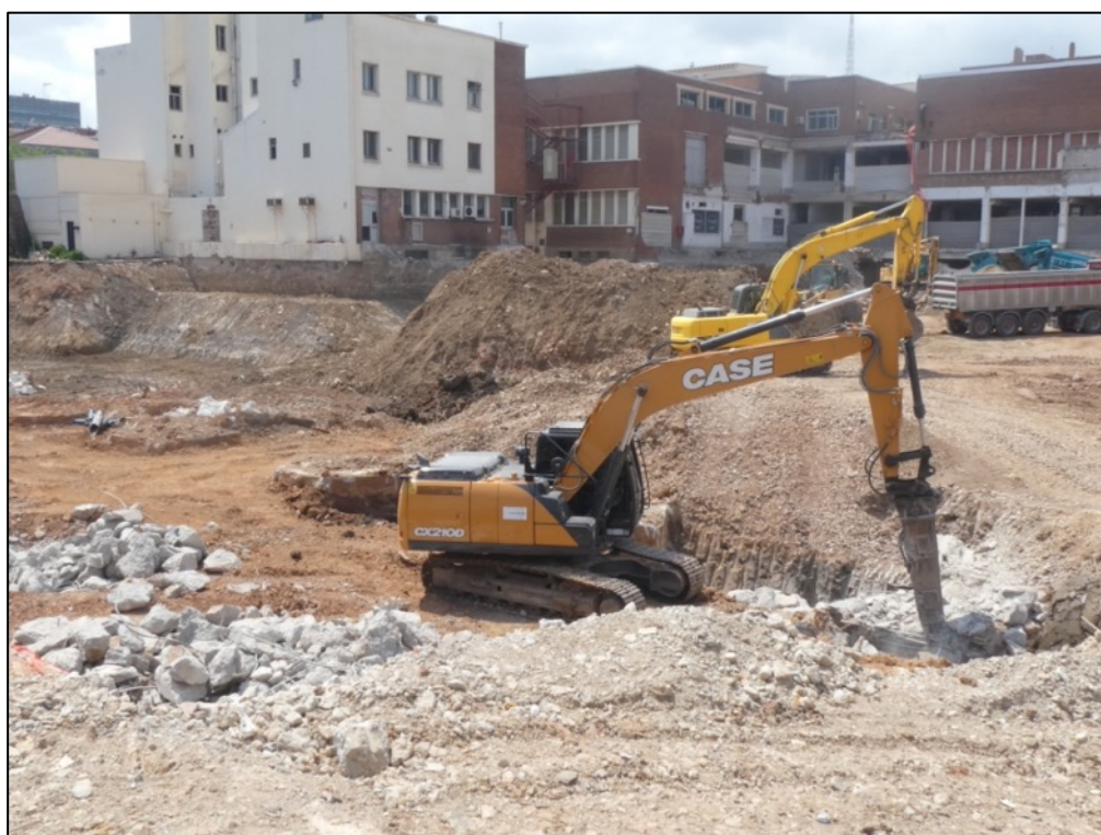
Fotografia 24. Desmuntatge fonamentacions de formigó situades en la zona central del sector A.
