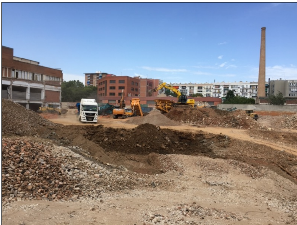
Fotografia 47. Vista zona central sector B durant els treballs de rebaix.
