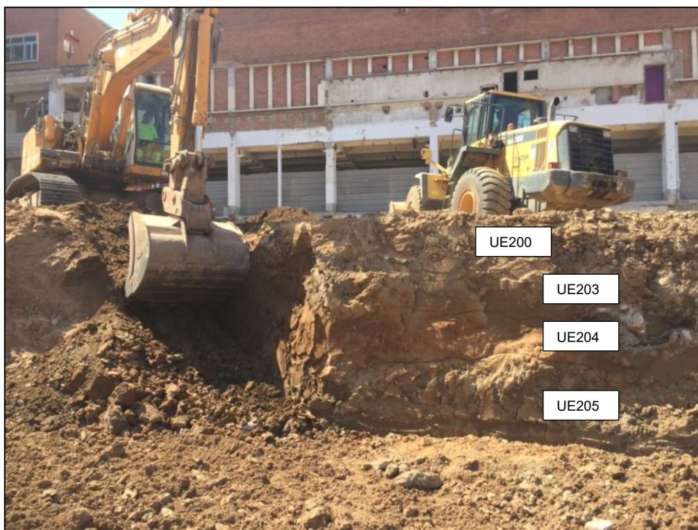
Fotografia 133. Excavació estratigrafia existent.
