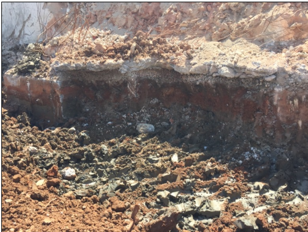
Fotografia 30. Detall fonamentacions de formigó tall oriental amb fangs de llacuna UE1000.
