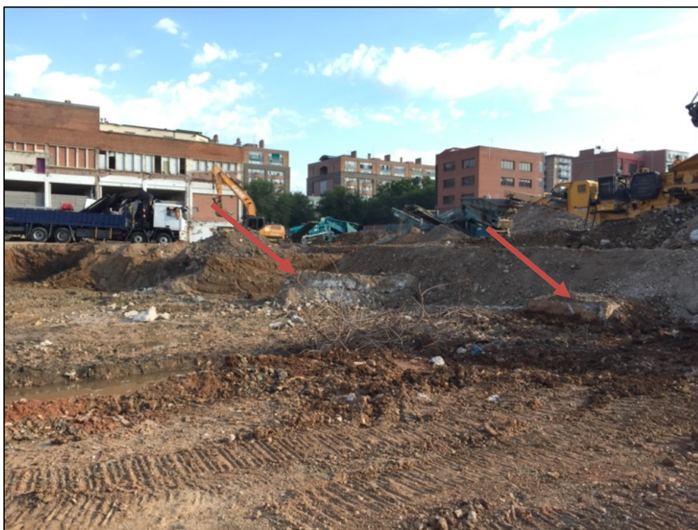
Fotografia 53. Fonamentacions de formigó.
