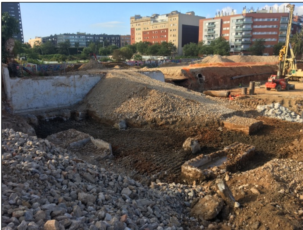
Fotografia 21. Vista dels diversos dipòsits de formigó localitzats en la zona nord del sector A.
