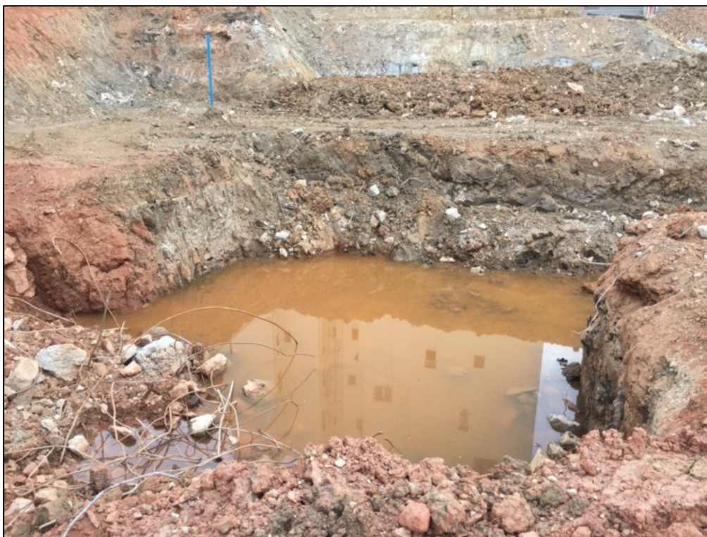
Fotografia 25. Aflorament del nivell freàtic a una cota de -1,5 metres snm.
