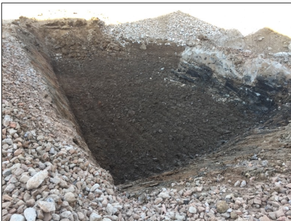
Fotografia 61. Zona sud un cop finalitzats els rebaixos.
