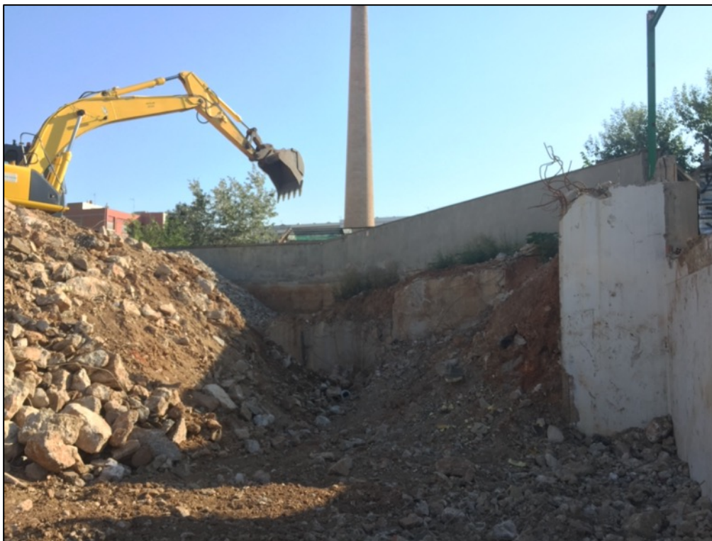
Fotografia 10. Rebaix nivells de runa contemporània zona depuradora situada a la cantonada NE del solar.
