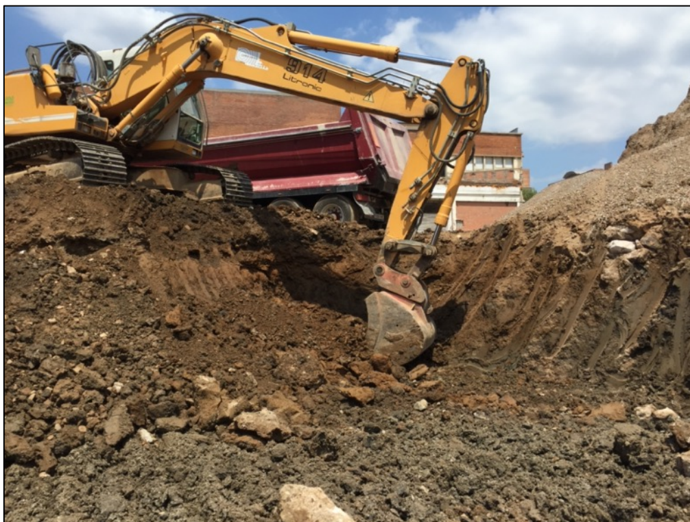
Fotografia 70. Excavació estrat UE104 format per aportació de sediments de riera.
