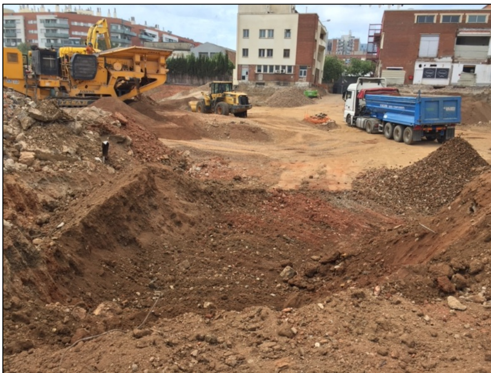
Fotografia 46. Treballs de rebaix dels sediments contemporanis UE100 en el sector B.
