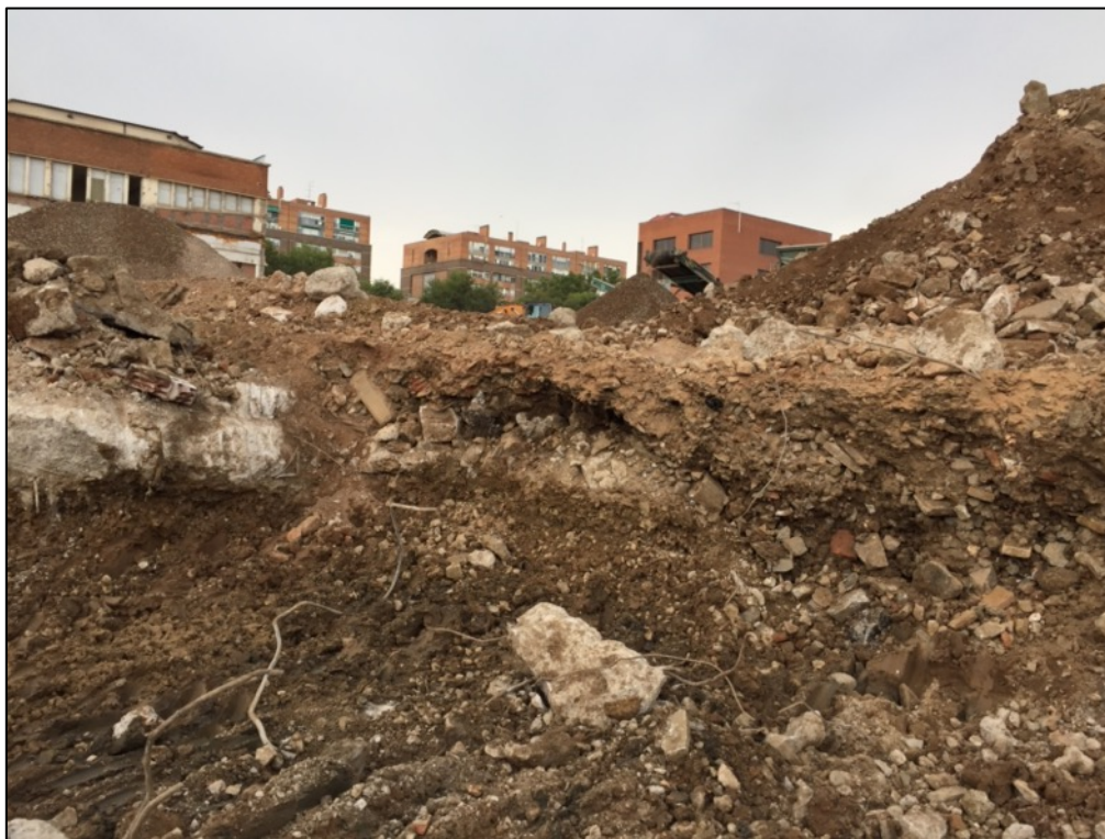
Fotografia 57. Vista tal estratigràfic zona nord amb runa i sediments actuals.
