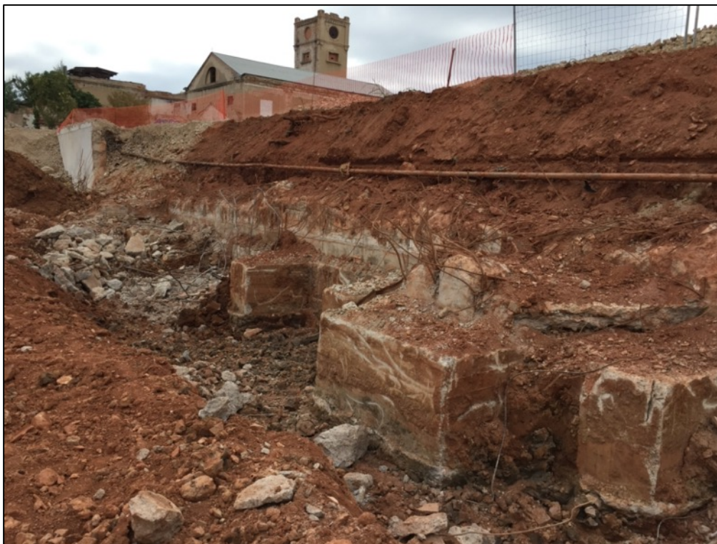
Fotografia 14. Vista de les fonamentacions de formigó de l'antiga fàbrica localitzades al tall oriental del solar.
