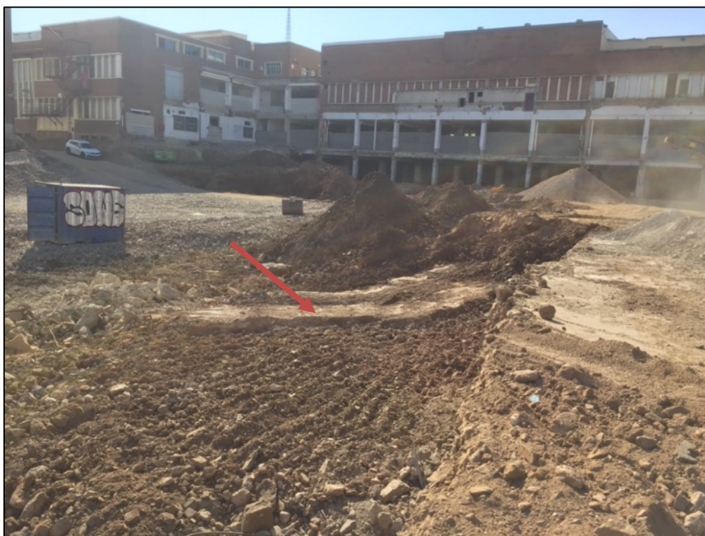
Fotografia 51. Línia de façana de formigó edificació fàbrica Farggi situada en la zona nord.
