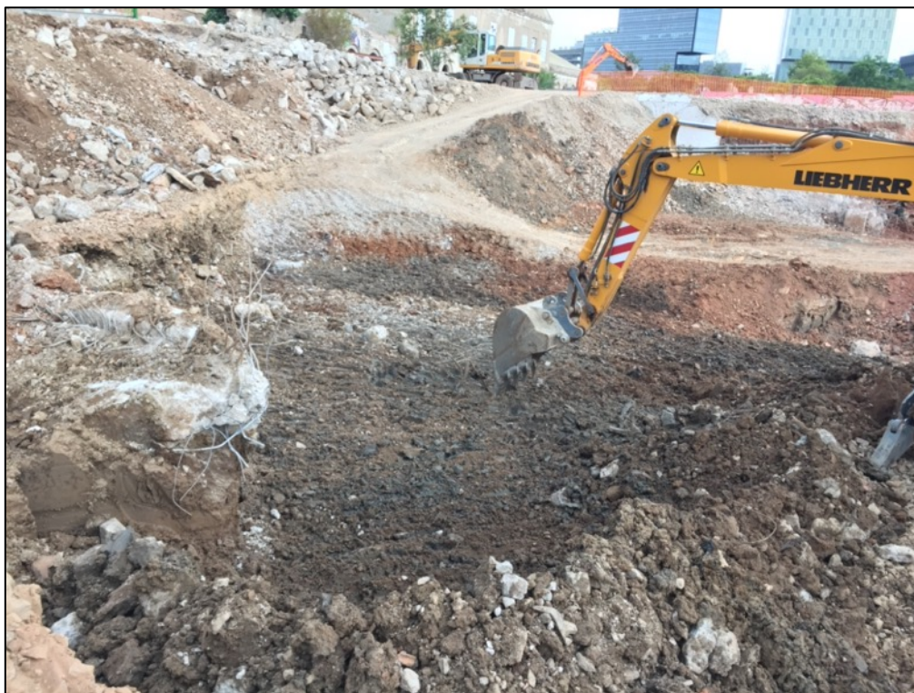
Fotografia 73. Rebaix fangs lacunars UE1000 localitzats en la zona central del sector B.
