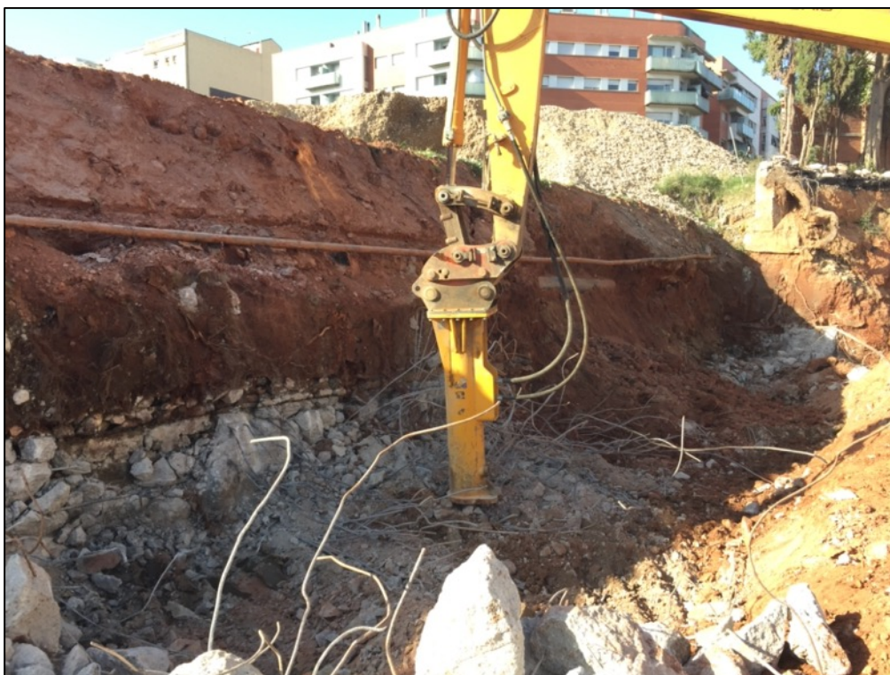
Fotografia 22. Desmuntatge de les fonamentacions de formigó localitzades al tall nord del sector A.
