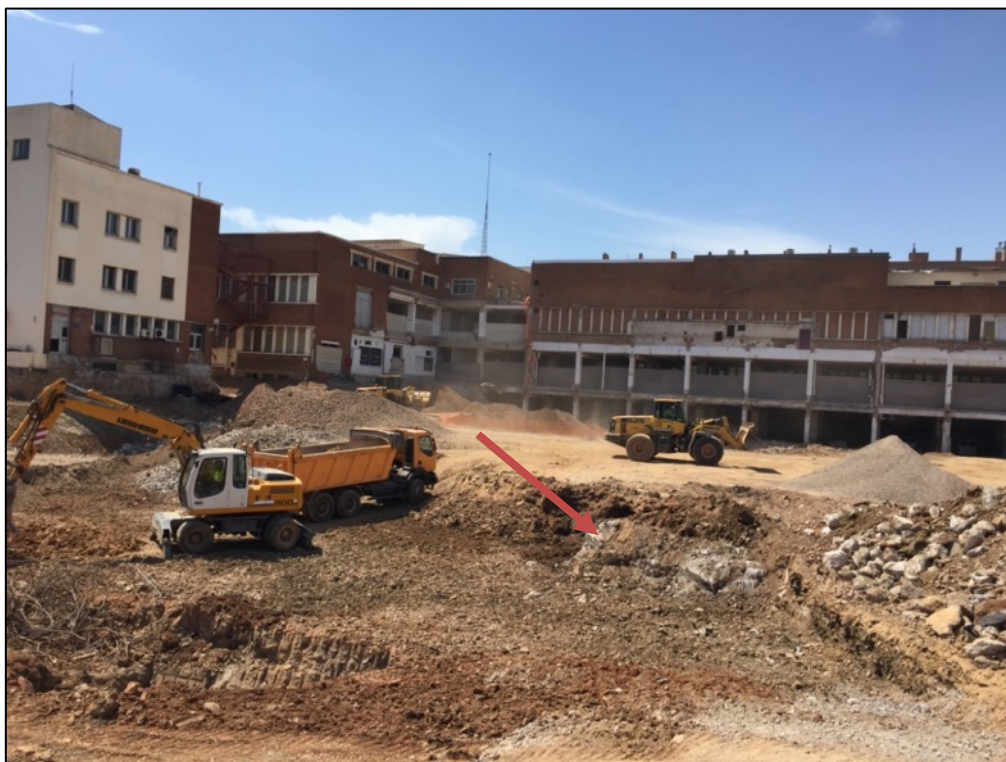
Fotografia 50. Restes de fonamentacions de formigó localitzades en la zona central del sector B.
