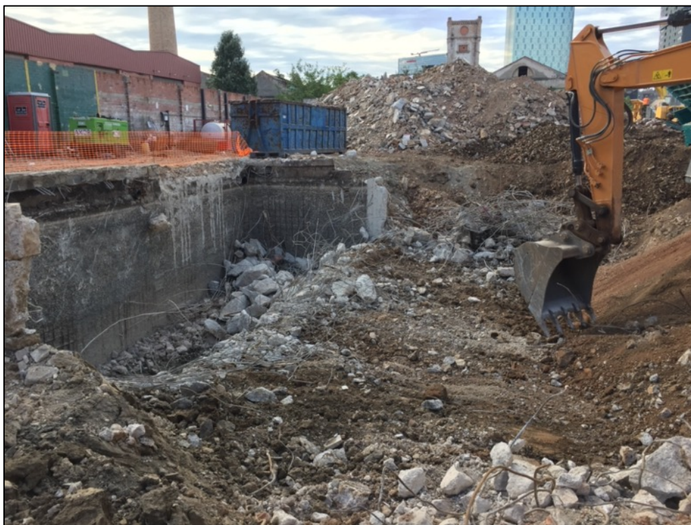
Fotografia 99. Desmuntatge estructures de formigó.
