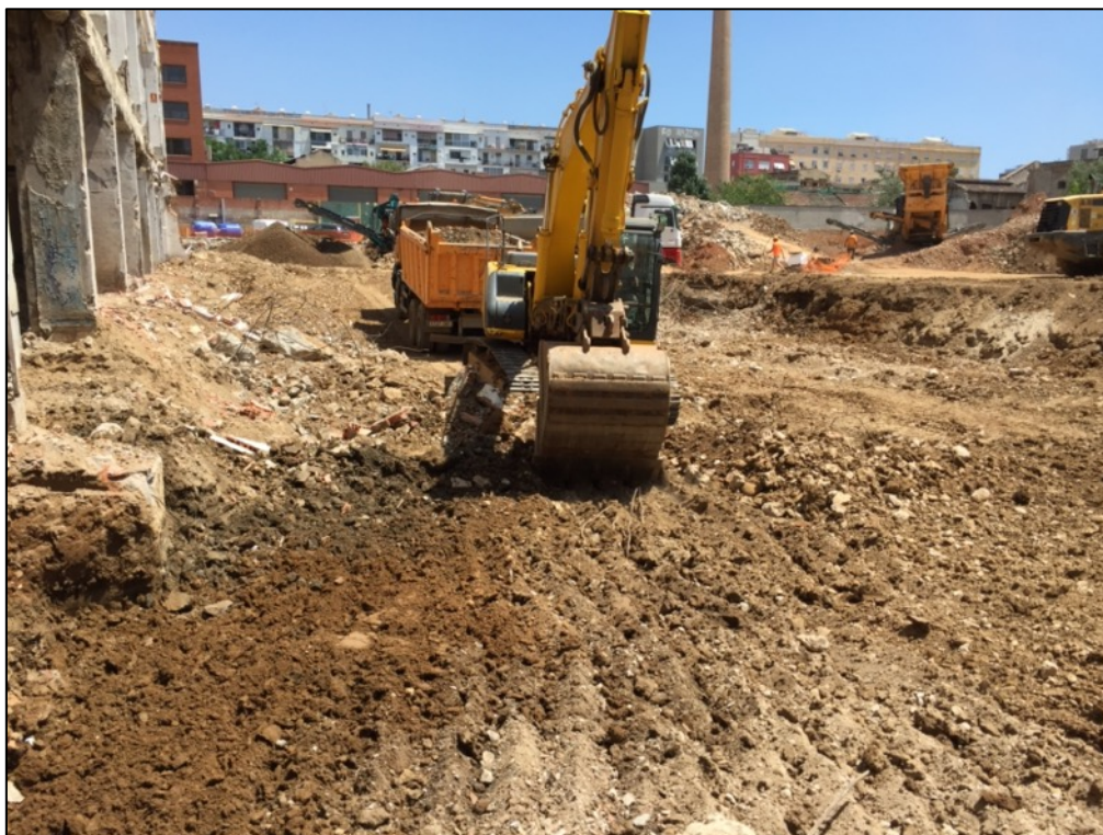
Fotografia 109. Excavació estrat UE205.
